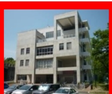
21世紀プラザ棟 創造工学センター
